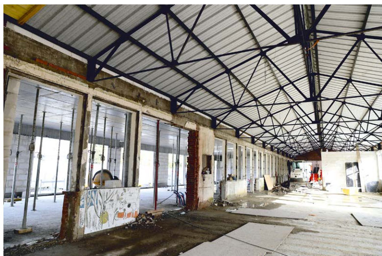
Le chantier au mois de février. Sur la gauche, l'une des extensions créées.
